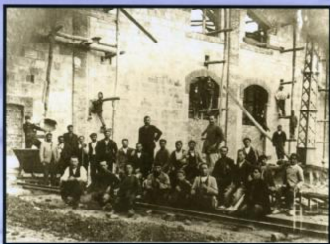
OBREROS CONSTRUYENDO EL EDIFICIO DE LA SALA DE MAQUINAS. Sobre 1914.
