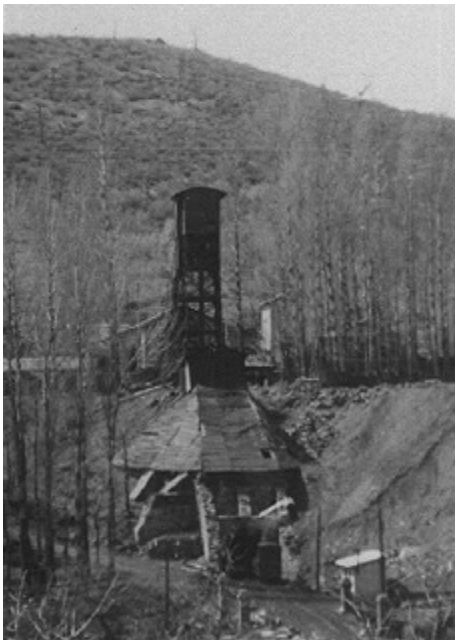
A la izquierda, el pozo Peñacorba y la salida de carbones al nivel Antoniana (fuente: www.barruelo.com ). Bajo la cubierta de madera, la criba donde se realizaba una somera clasificación del carbón. A la derecha, estado actual del nivel Antoniana. De la plaza de Peñacorba sólo queda la explanación y algunos restos de edificios.
